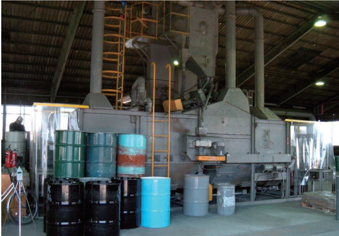
図 3-2a : ショットブラスト出入口にカーテンを設けたところ、周囲の騒音が低減
